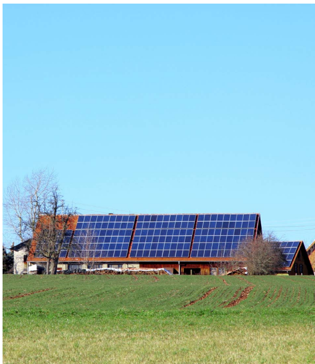
Den extra belastningen ställer krav på bland annat stomme, takåskonstruktion och plintar.
