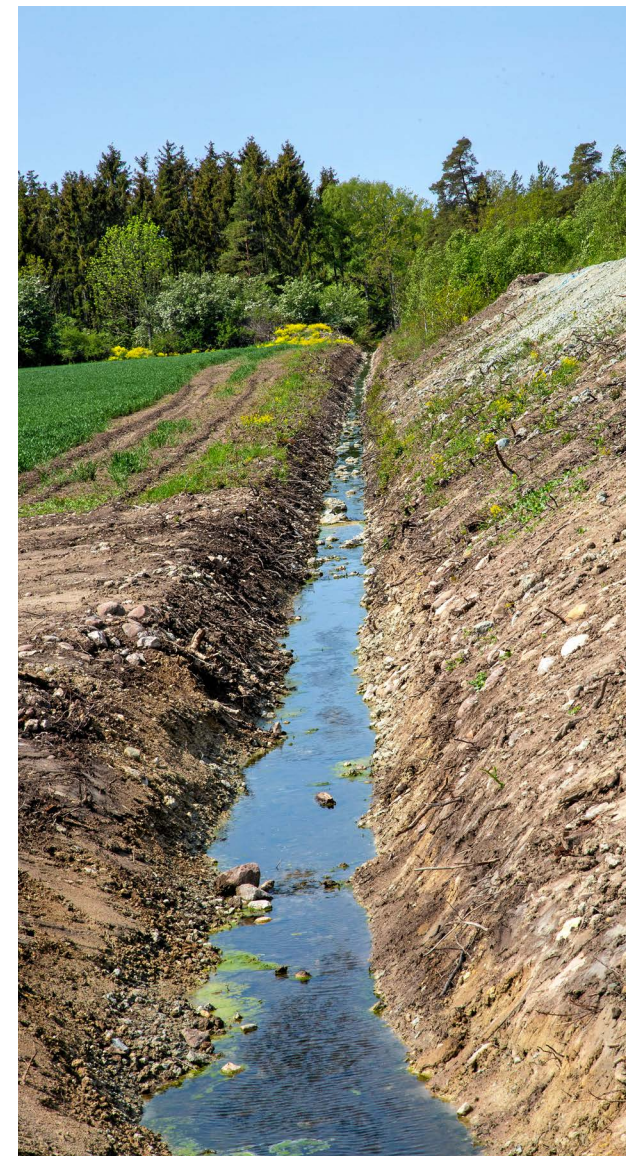
Härifrån tillförs vattnet till den nya dammen. Svante Runfeldt har rätt att ta ut 100 000 kubikmeter från det lokala vattendraget.
