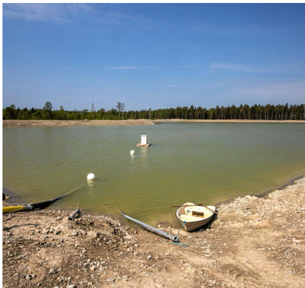
En damm på 150 000 kubikmeter har anlagts under vintern för att samla vatten som ska användas till den nya bevattningsanläggningen.
