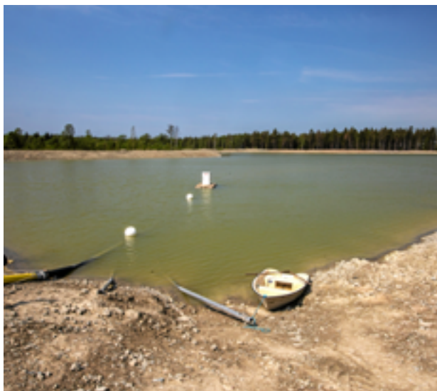
En damm på 150 000 kubikmeter har anlagts under vintern för att samla vatten som ska användas till den nya bevattningsanläggningen.
