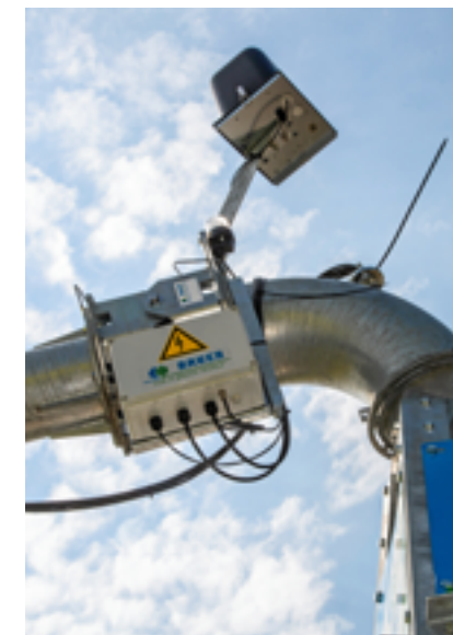
GPS-mottagaren och styrutrustningen på anläggningen reglerar magnetventilerna.
