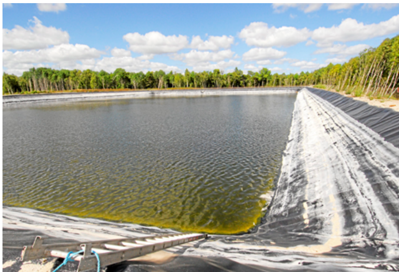
Bevattningsdammen i Östergarn på Gotland rymmer 50 000 kubikmeter.
